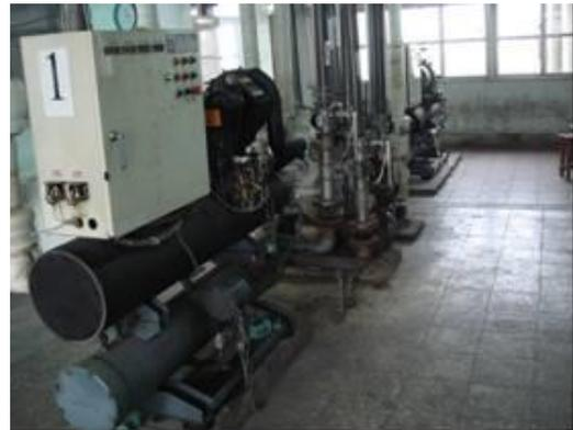
備註：具有相態變化(水蒸氣  $\leftrightarrow$  水)之冷凝器及蒸發器
